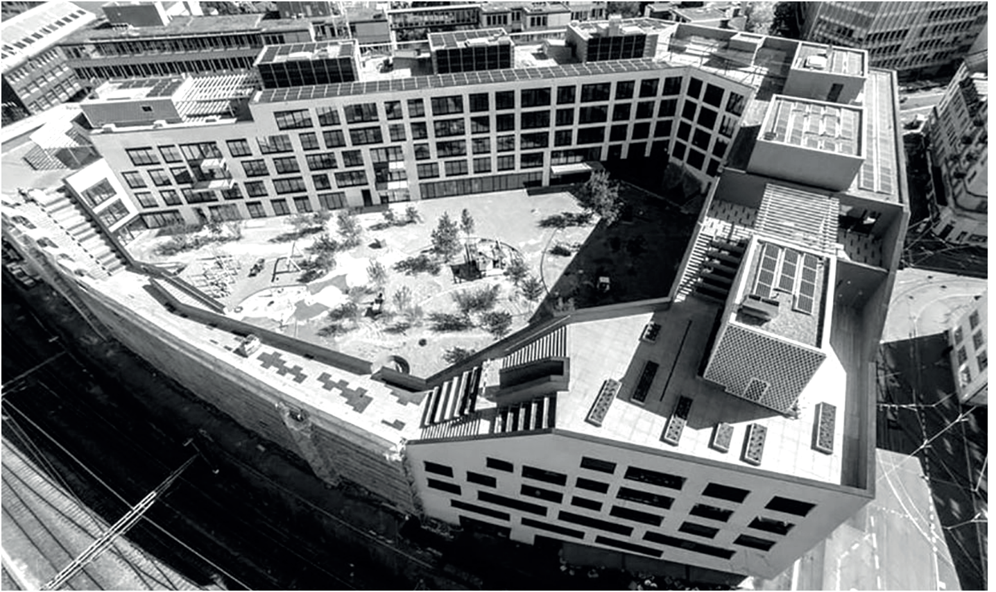
'Kalkbreite' in Zürich
